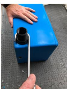
Ziehen Sie die hintere Mutter mit einem geeigneten Werkzeug an. Achten Sie darauf das Gewinde nicht zu beschädigen.
